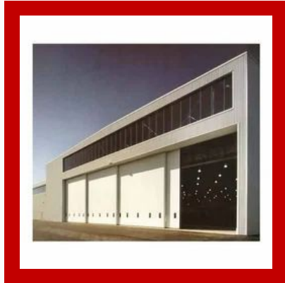
Automatic Hanger Door
